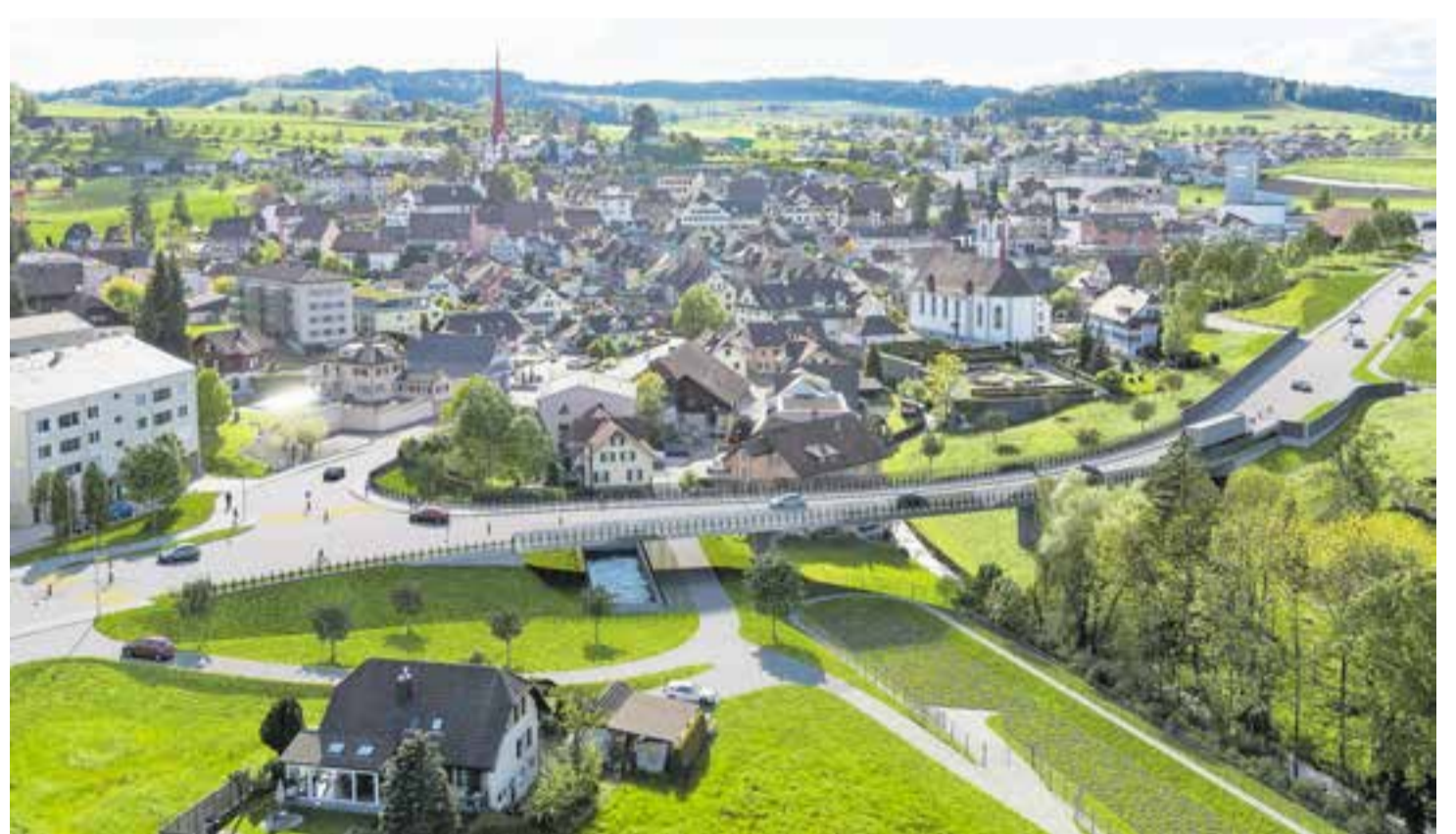
Eine Brücke über die Wyna soll als Teil der Umfahrung den Beromünsterer Flecken entlasten.
